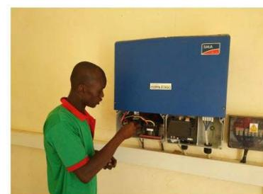
Figure 4 Vérification d'un onduleur photovoltaïque
