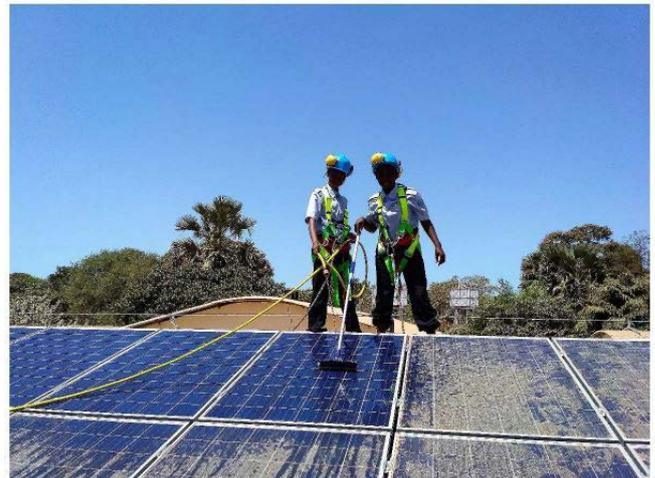
Figure 2 Nettoyage des panneaux photovoltaïques
