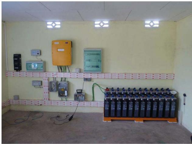
Figure 9 Exemple de système couplé en CC.
