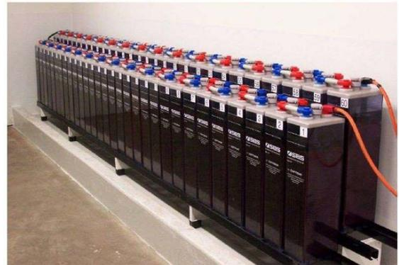
Figure 3 Banc de batteries d'installation photovoltaïque
