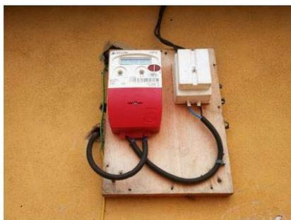
Figure 6 Compteur prépayé dispensateur d'énergie
