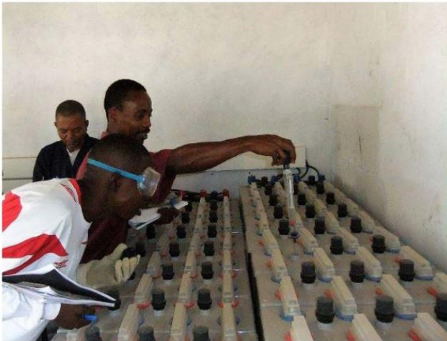
Figure 1 Contrôle de la densité de l'électrolyte des batteries
