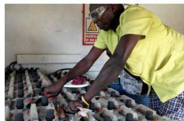
Figure 3 Nettoyage et graissage des bornes des batteries
