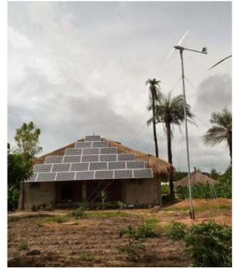
Figure 7 Installation hybride PV-éolienne en Gambie.
